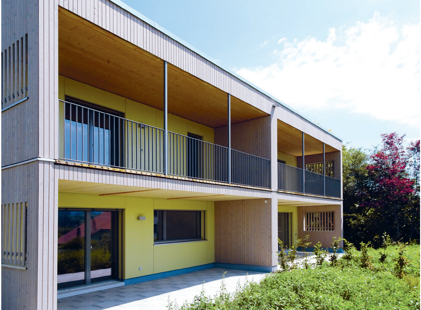
Für sämtliche Gebäude der Überbauung Waldegg kamen vorgefertigte Holzelemente zum Einsatz. Die Dächer und Decken wurden aus verleimten Kastenelementen hergestellt.
